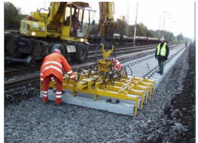
Die Aufnahme am Bagger kann durch Standardanbau mit Bolzen oder mit Schnellwechsellvorrichtung erfolgen.
